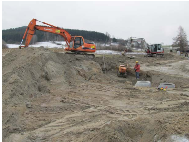
Bild: Kanalbauarbeiten Prammerfeld Bildrechte: Marktgemeinde Leopoldschlag
